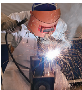
被覆アーク溶接実習
